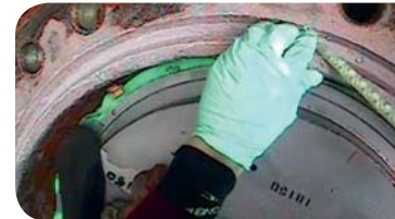
Fig. 2 Epoxy primer application
