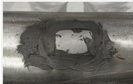
Le pipe est désormais prêt à être renforcé avec le REINFORCEKIT® 4D (R4D), en suivant les normes.
