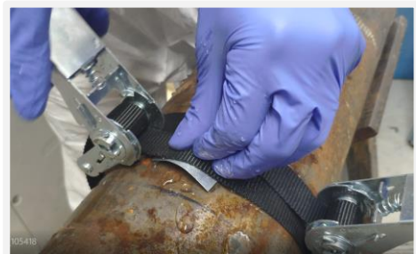
Positionner le mastic pré-réticulé sur la fuite
