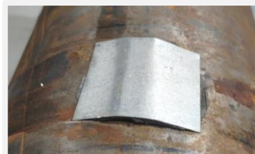
Retirer le système de sangles à cliquet et la plaque en acier galvanisé
