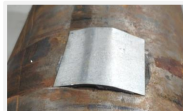
Retirar el sistema de correas de trinquete y la placa de acero
