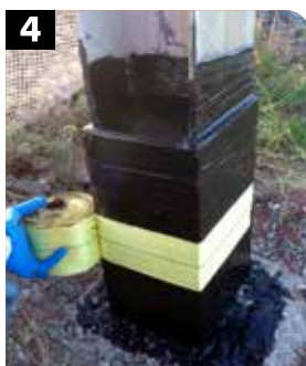
4 Enroulement Kevlar® et résine époxy
