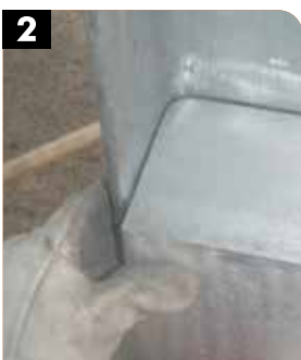
2 Préparation des inserts métalliques
