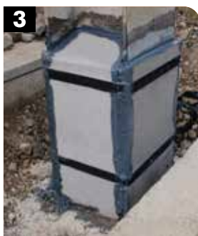
3 Installation des inserts métalliques
