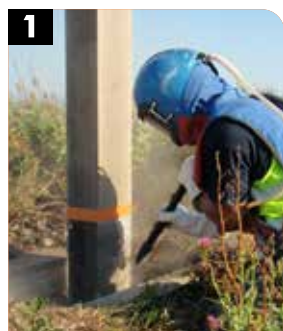
1 Préparation de surface Sa2½ / St3 et rugosité Rz > 60 µm
